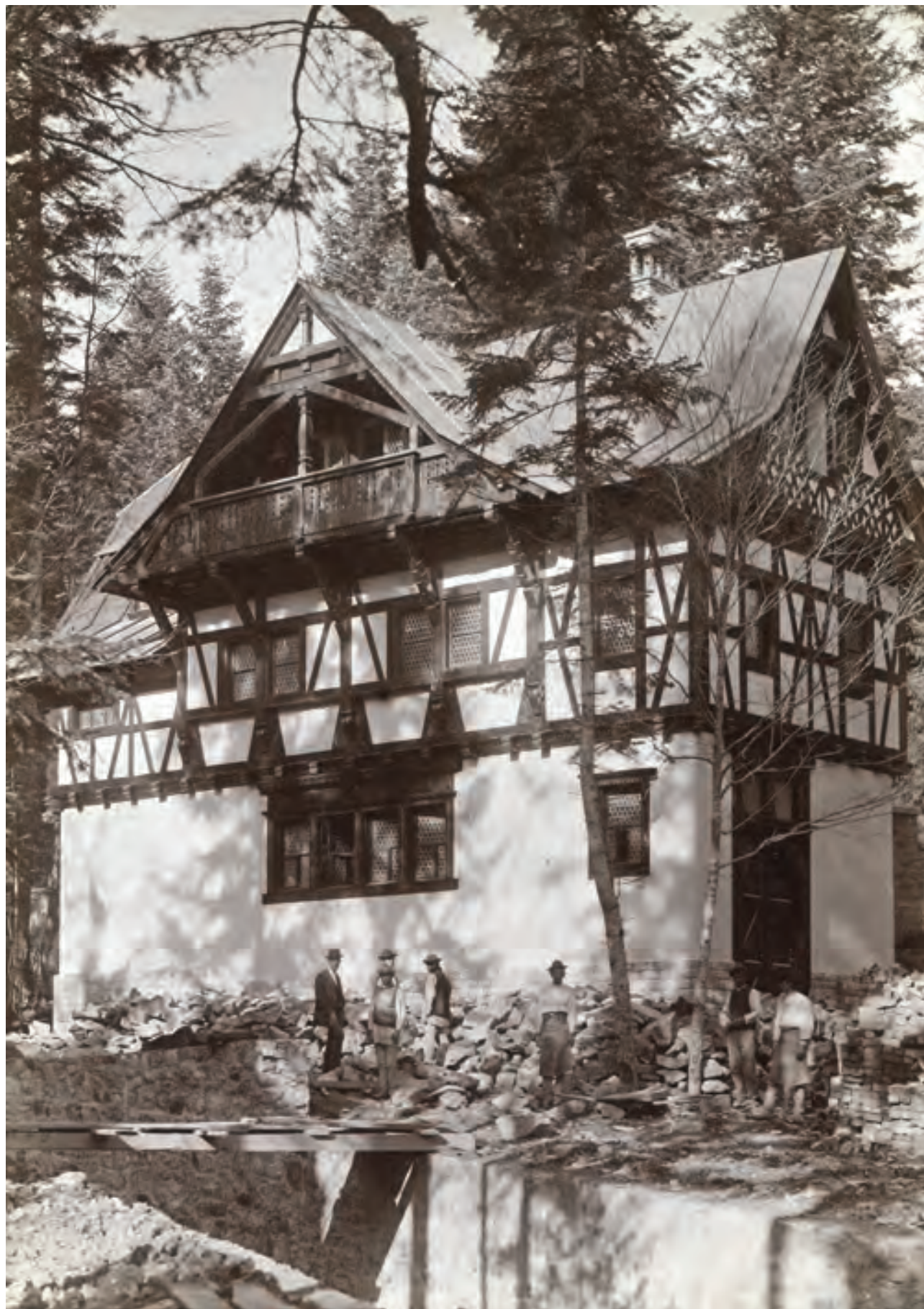
Casa arhitectului Liman, în construcție, cca 1909
