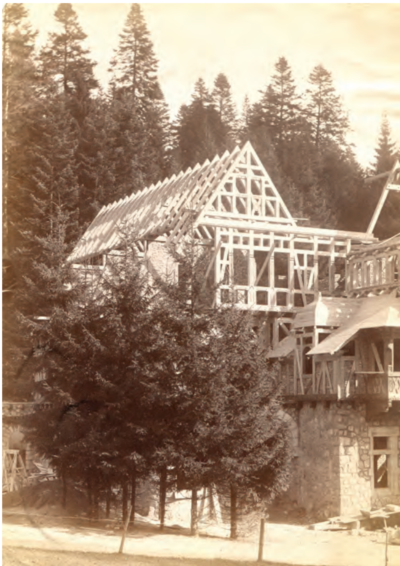
Castelul Pelișor în construcție, fațada de vest, cca 1901
