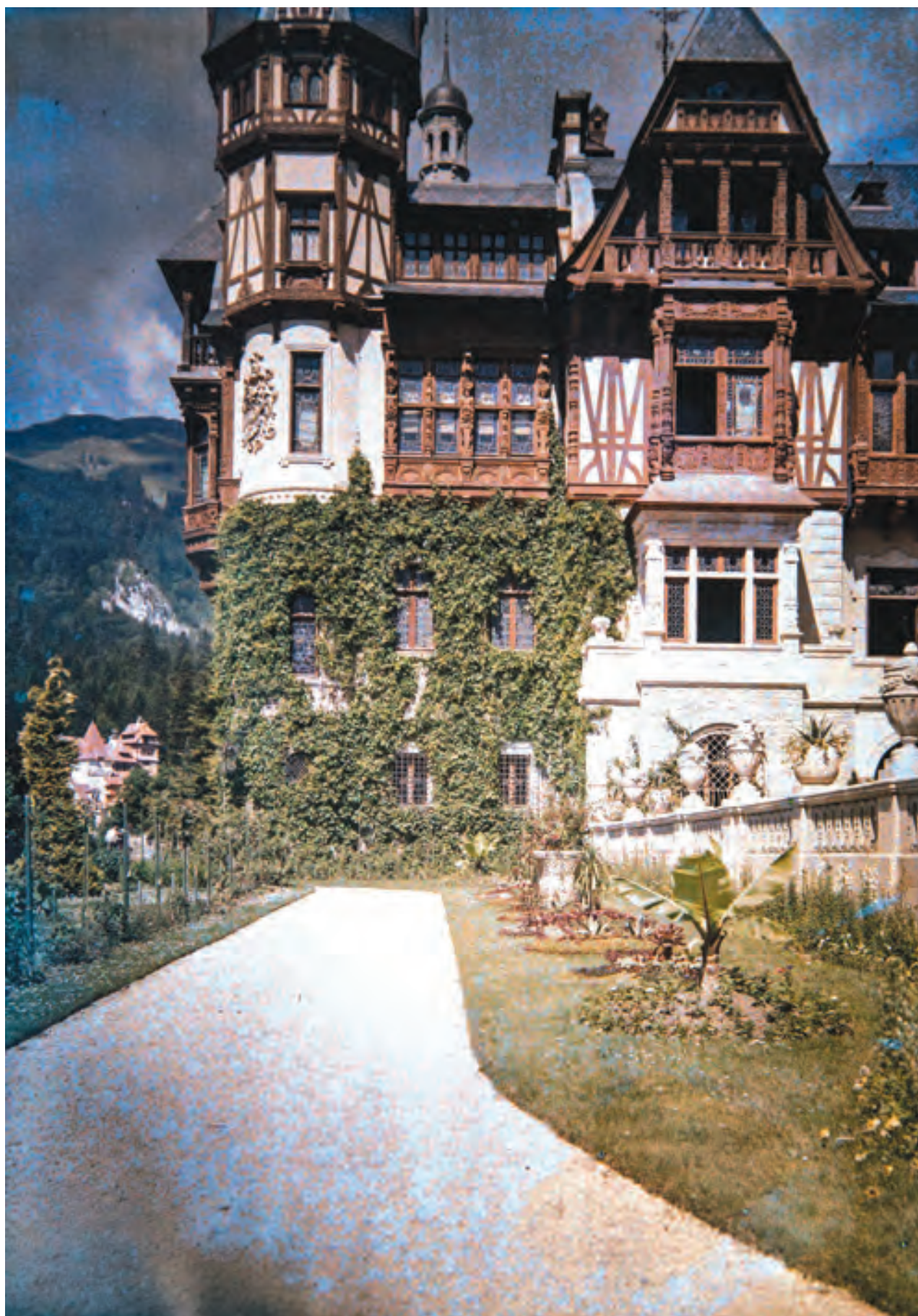
Detaliu al fațadei de răsărit, cca 1910
