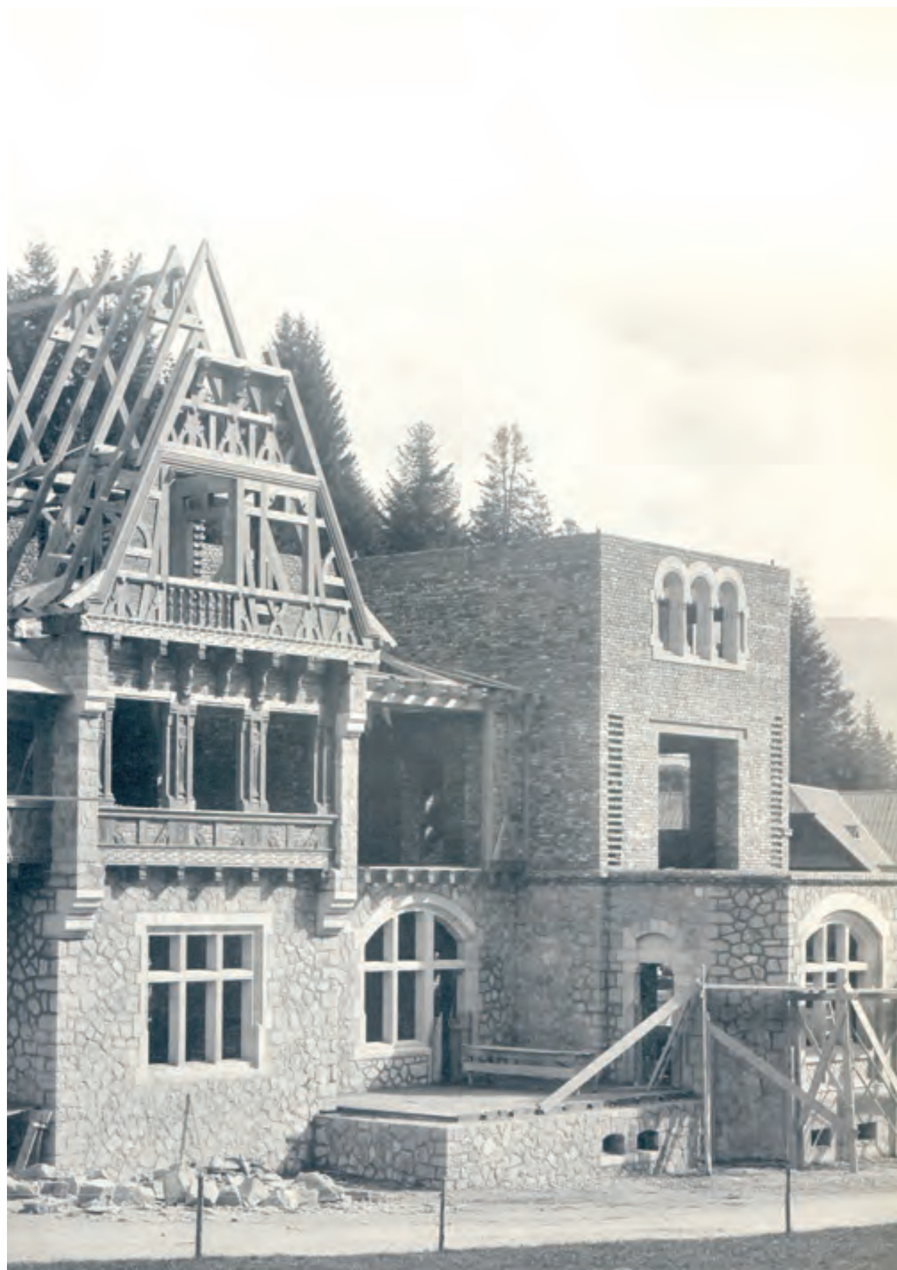
Castelul Pelișor în construcție, cca 1900
