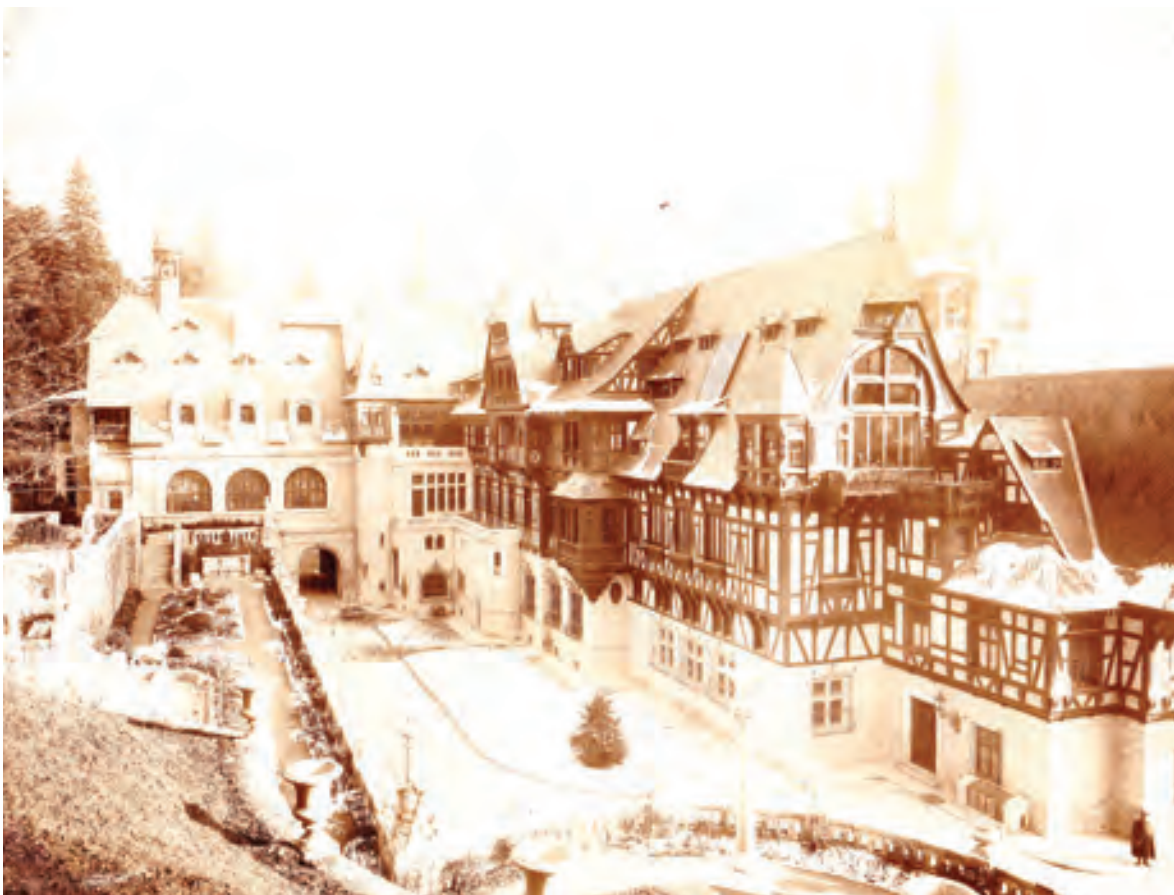
Fațada de nord dinspre terasa de vest, cca 1912
