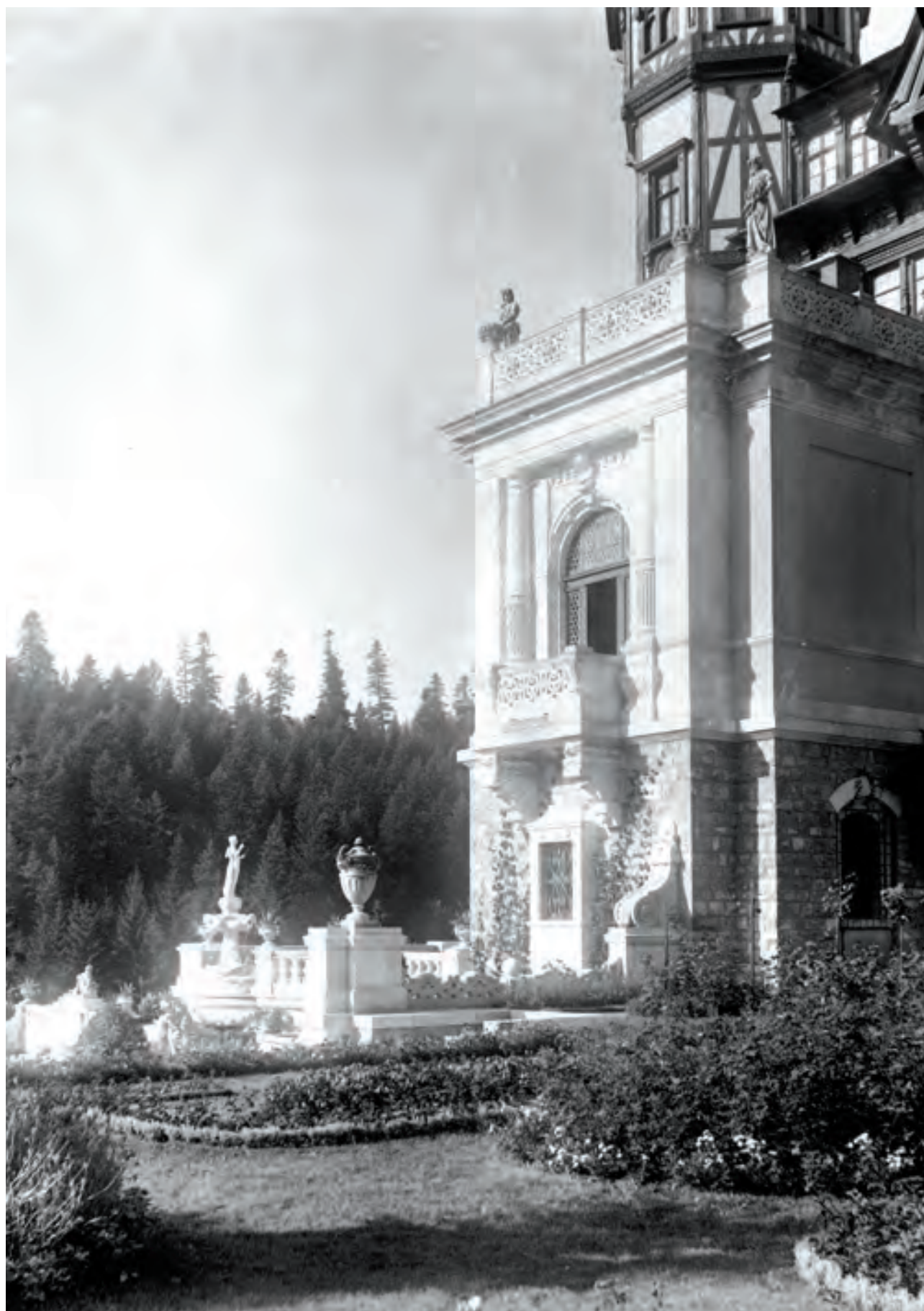
Detaliu al fațadei de răsărit, cca 1914
